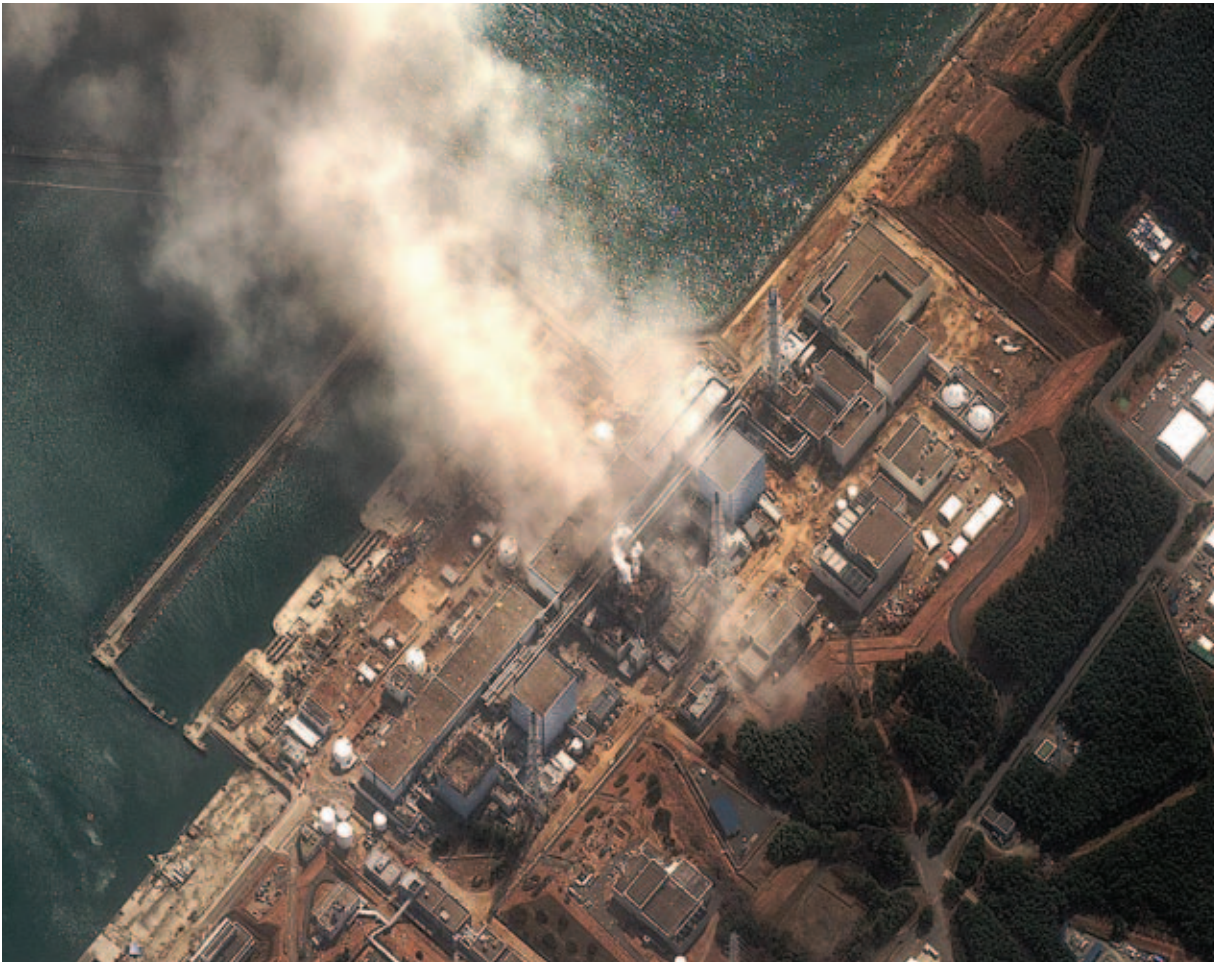
Image Vue satellite des dommages infligés à la centrale nucléaire de Fukushima, consécutifs au séisme survenu au large des côtes japonaises le 11 mars 2011.
